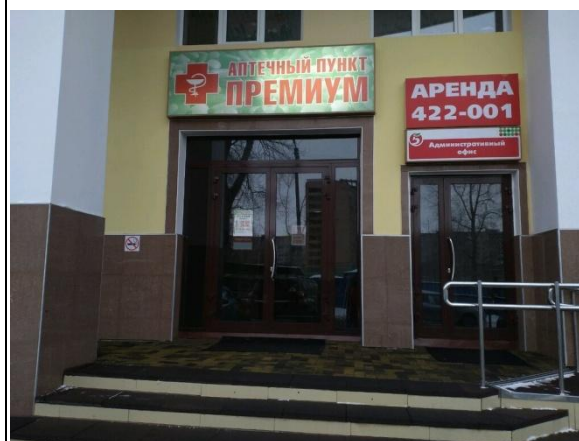
Аптека «Премиум» Адрес: г. Архангельск, ул. Свободы, д. 29 Результаты (состояние объекта): есть пандус, сделан мягкий настил на крыльце
